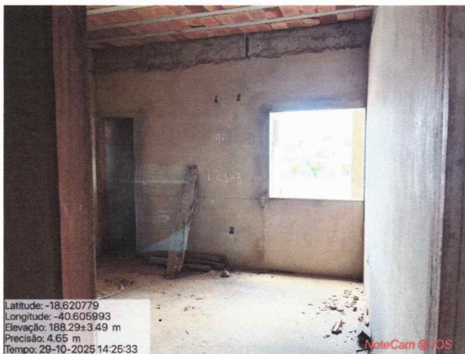
Paredes com reboco em todas as paredes internas; janelas com acabamento em granito nas laterais; portas com marcos em madeira devidamente fixados, porém sem as folhas instaladas; caixas de passagem e conduítes instaladas nos cômodos, indicando preparo para a execução das instalações elétricas e de dados.
