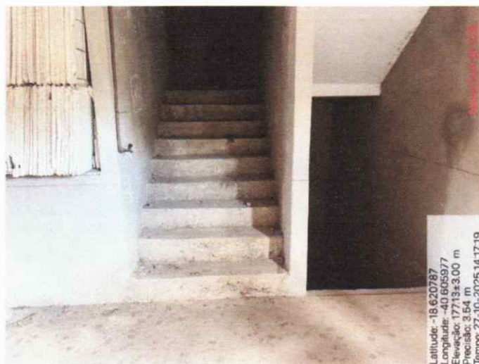
Paredes com reboco em todas as paredes internas.
