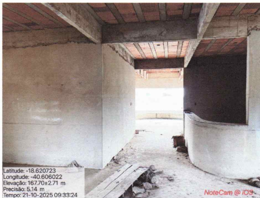
Paredes com reboco em todas as paredes internas; caixas de passagem e conduítes instaladas nos cômodos, indicando preparo para a execução das instalações elétricas e de dados.
