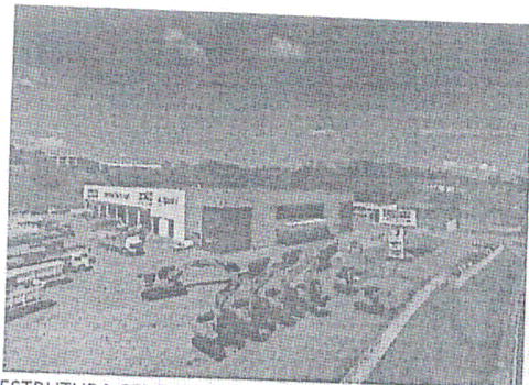
ESTRUTURA CENTRO OESTE
